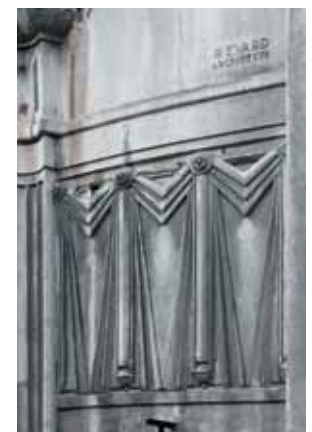
Drapé géométrique de la façade de l'ancienne Justice de Paix. Ces drapés qui traduisent dans la pierre les étoffes accrochées aux parois à l'occasion des grandes solennités présentent des plis aigus dans le goût géométrique de l'époque.
