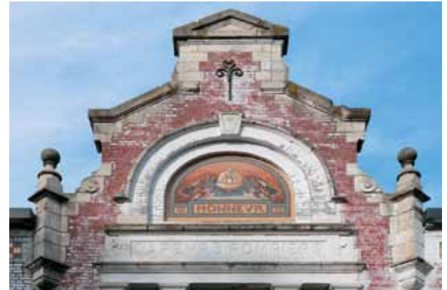
Fronton-pignon de l'ancien hôtel des sapeurs-pompiers.
