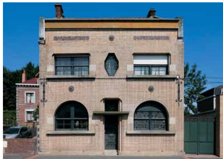
Maison, rue Pasteur, Marles-les-Mines. Dans cette écriture architecturale d'une grande rigueur seul le tracé des ouvertures évoque l'Art déco.
