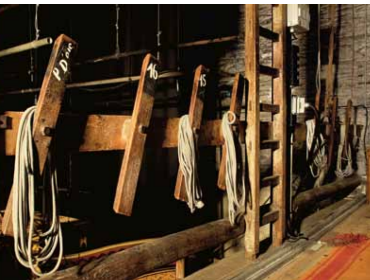
Détail des anciennes pièces de bois des cintres.
