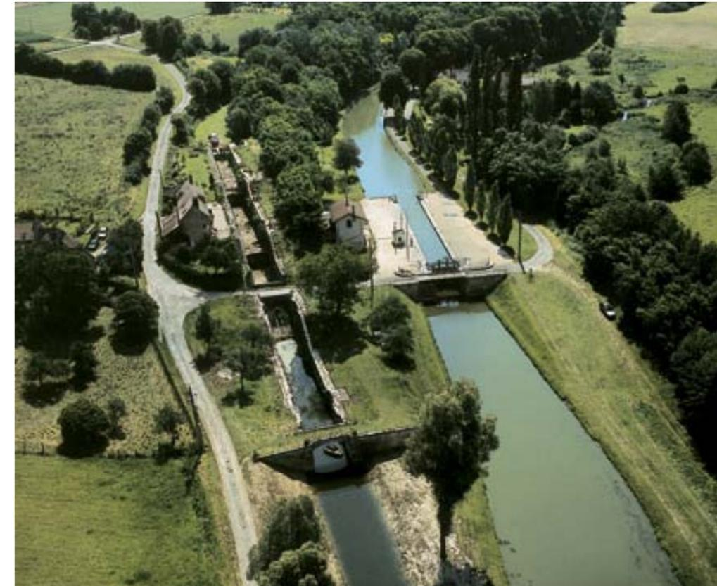
A partir du milieu du XIX<sup>e</sup> siècle, les échelles d'écluses sont remplacées par des écluses séparées par un bief permettant le croisement des bateaux entre chacune d'elles, limitant ainsi les pertes de temps au passage de ces ouvrages. Au Moulin Brûlé, à Dammarie-sur-Loing (Loiret) sur le canal de Briare, l'ancien tracé comprenant quatre écluses est encore visible près du nouveau bief creusé à l'extrême fin du XIX<sup>e</sup> siècle. Photographie aérienne de Michel Berger.
