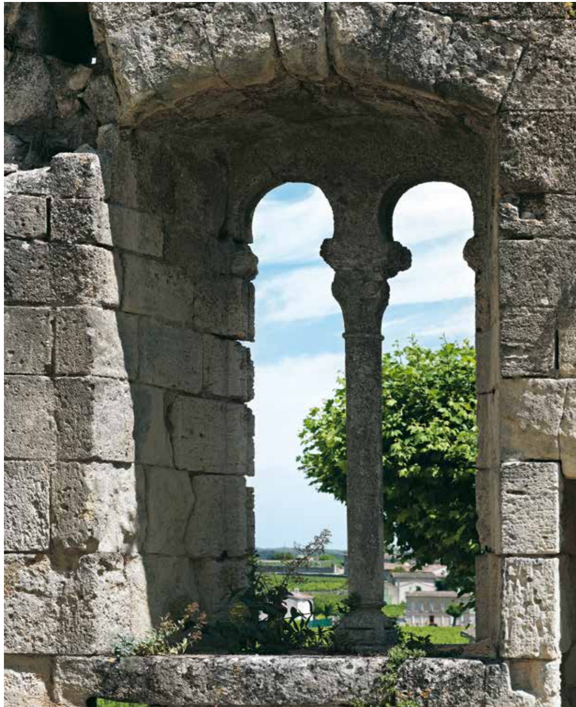
« Palais Cardinal », revers de la façade sur le fossé : détail d'une baie géminée.
