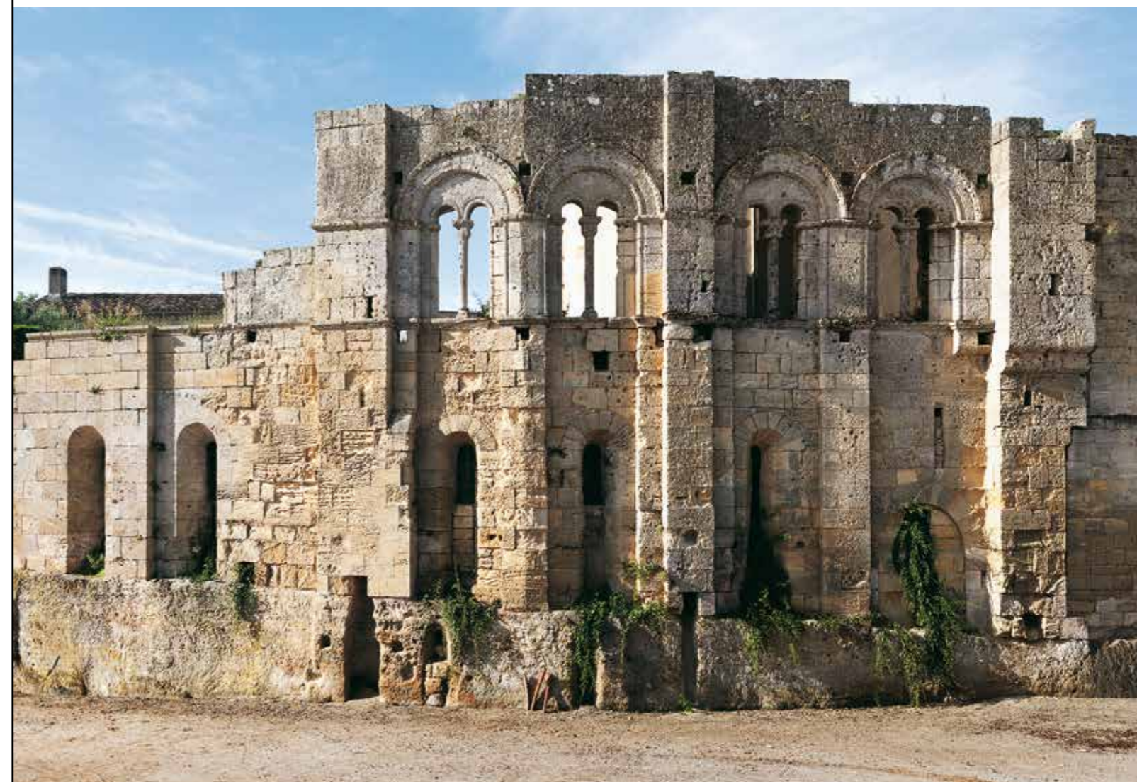
5. 30. « Palais Cardinal » : détail de la façade donnant sur les fossés avec exutoires de latrines.
