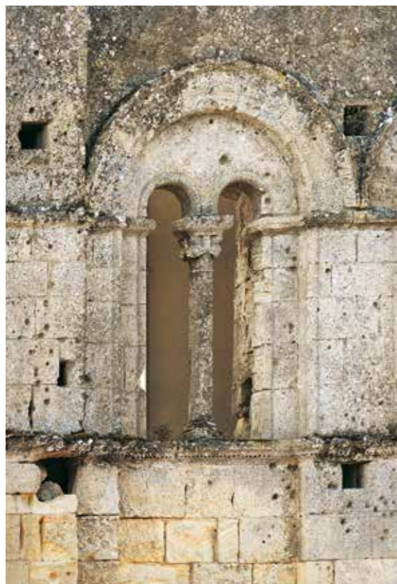
5. 21b. « Palais Cardinal » : fenêtre géminée à la modénature particulièrement raffinée.
