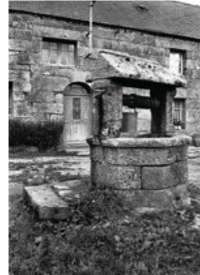
61 — Saint-Nicodème (22), le Grand Faut. Puits octogonal daté de 1670. Il s'agit d'un des premiers puits datés à traverse.
