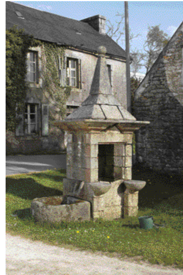
62 — Berrien (29), Kernevez. Puits, 1852. Puits de village très soigné avec repose-seaux et goulotte d'évacuation de l'eau vers l'auge.
