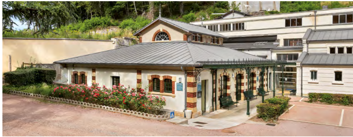
Saint-Honoré-les-Bains, pavillon des douches de l'établissement thermal. Il est aujourd'hui occupé par des bureaux administratifs. Aquidebis aut et,
