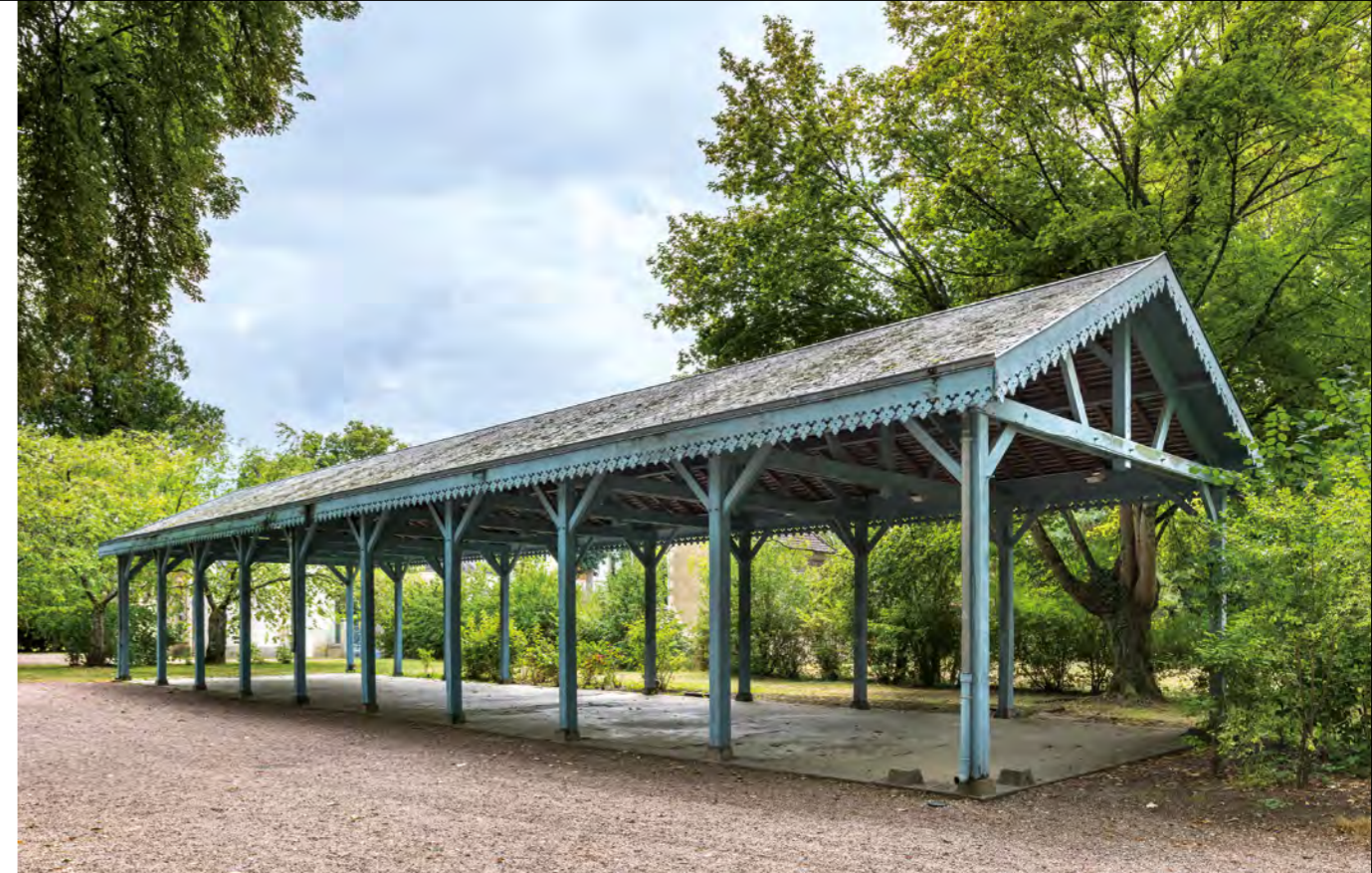
Pougues-les-Eaux, halle en bois dans le parc thermal, récemment rebâtie sur le modèle de celle construite au milieu du XIX e siècle.
